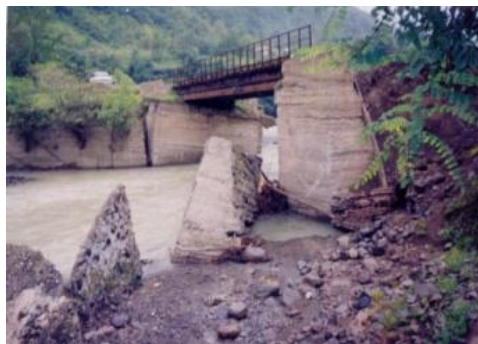
ნახ. 2. 2003 წლის წყალმოვარდნის შედეგად დაზიანებული ხიდი (მდ. ხანისწყალი) (ფოტო ს. გორგიჯანიძის)
